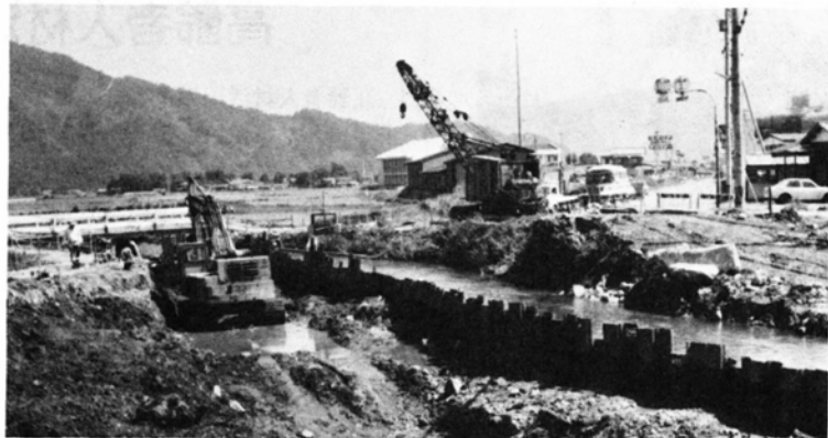
工事が始まった中野橋
