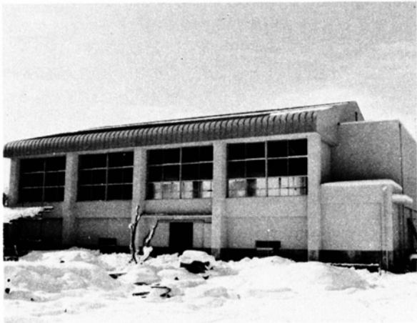
完成した阪谷小体育館
