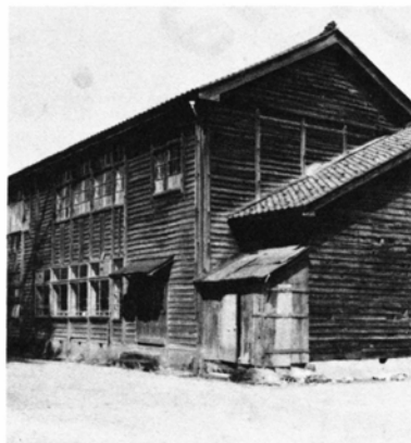
建てかえられる上庄小の校舎
