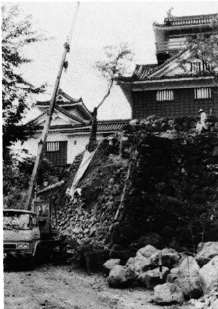
改修される石垣
