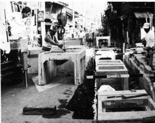
整備される流雪溝(春日通り)
