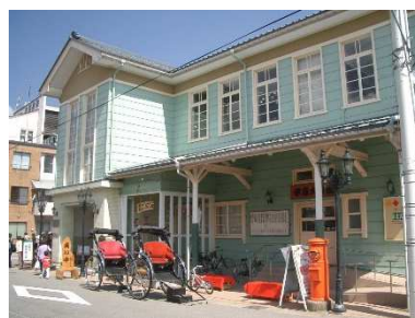
平成大野屋本店洋館
