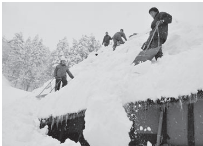
重要文化財旧橋本家住宅の屋根雪下ろし
