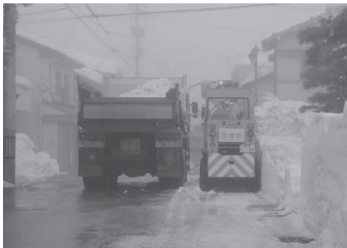
小型除雪車による除排雪
