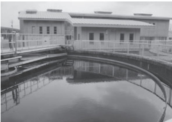
下水処理センター
