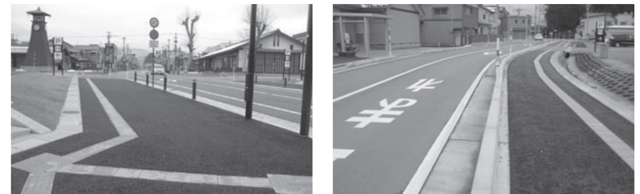
バリアフリー工事を実施した歩道 (左) 市道六間線 (右) 市道七間六間線
