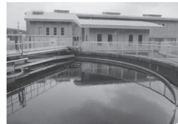
下水処理センター
