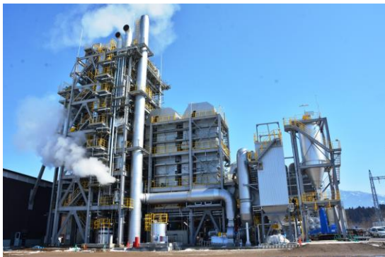
木質バイオマス発電所
