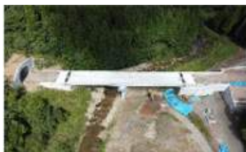
◆ 中部縦貫自動車道大野油坂道路 (新多母谷橋 施工状況)
