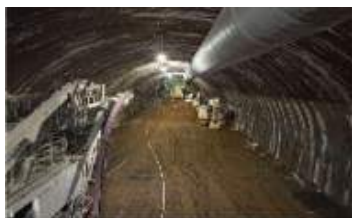
◆ 中部縦貫自動車道大野油坂道路 (新下半原トンネル 施工状況)
