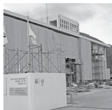
「開成中学校での耐震補強工事」
