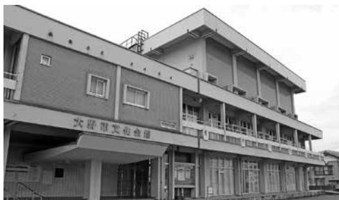
建築後約50年が経過した文化会館
