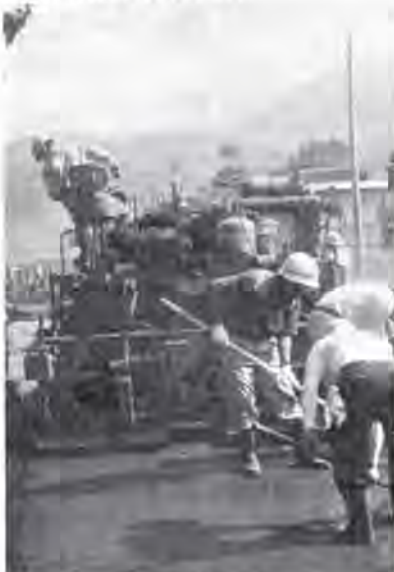
市道の舗装工事
