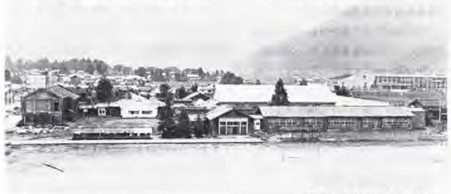
開成中学校旧校舎の一部を有終会館として改造
