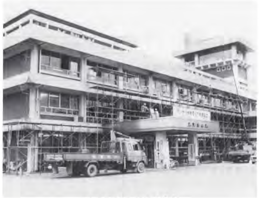
外装改修工事中の市庁舎
