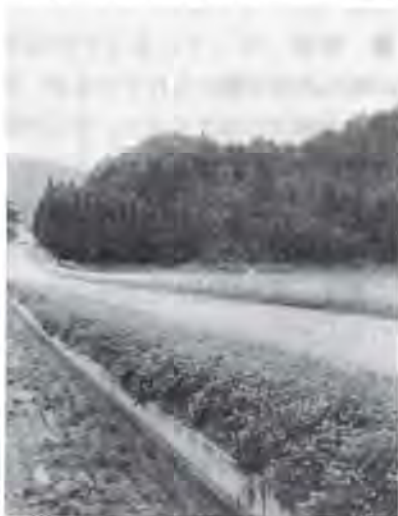
上水道の配水池に予定されている越坂付近
