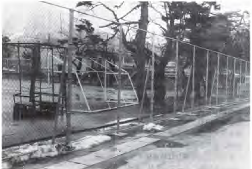
亀甲積み石垣が取り壊されフェンスが張られた有西小
