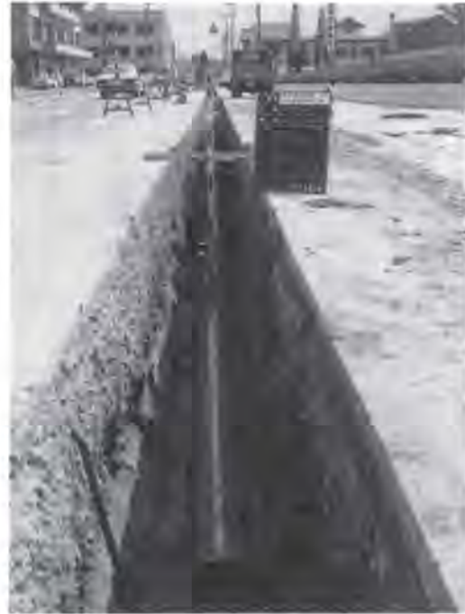
拡張工事が進む上水道事業
