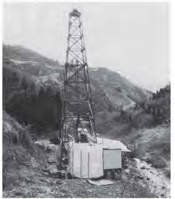
良質の温泉が期待される掘削工事
