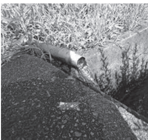
地下水揚水の現場
