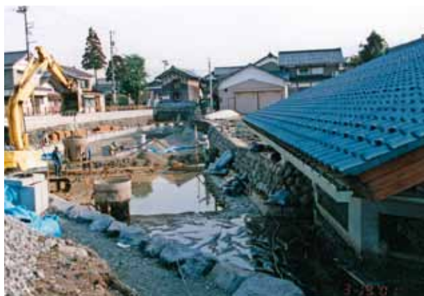
改修工事中（平成12年）
