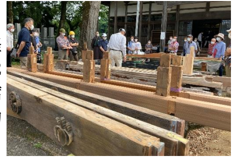
解体され、繕われた部材(写真は見学会)
