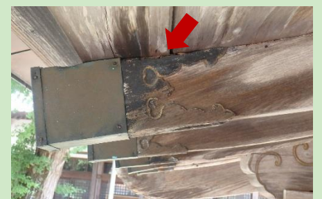
銚金具風に彫り出した垂木 (先端の銅板は後世の養生)
