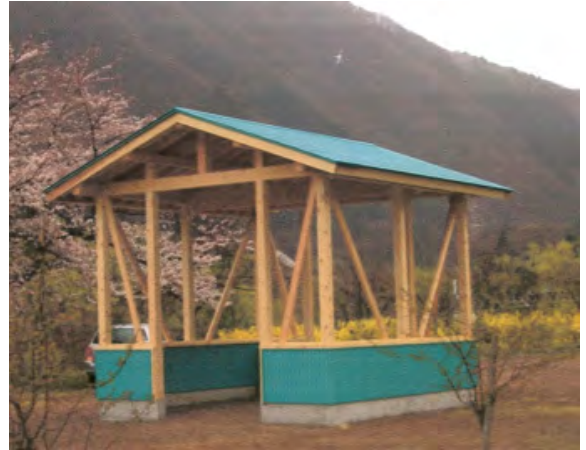
【花桃園地整備（H27）】 休憩施設（東屋）完成
