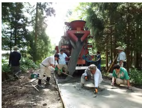
下黒谷地区の雪崩防護壁管理道路コンクリート舗装
