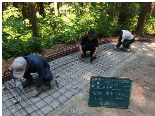
上荒井地区の集落作業道整備
