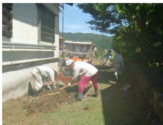
深井地区の集落センター周辺整備
