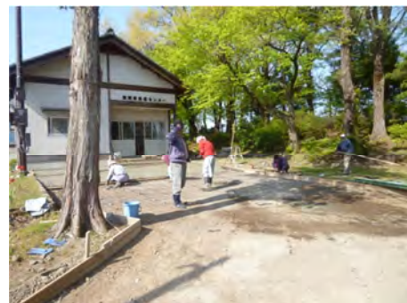
新塚原区集落センター敷地改修 (H25)
