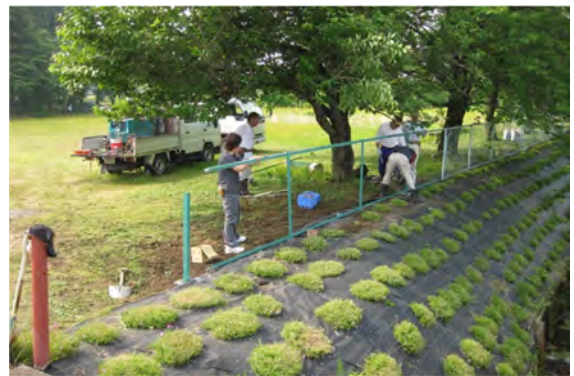
塚原区安全柵修繕（H23）
