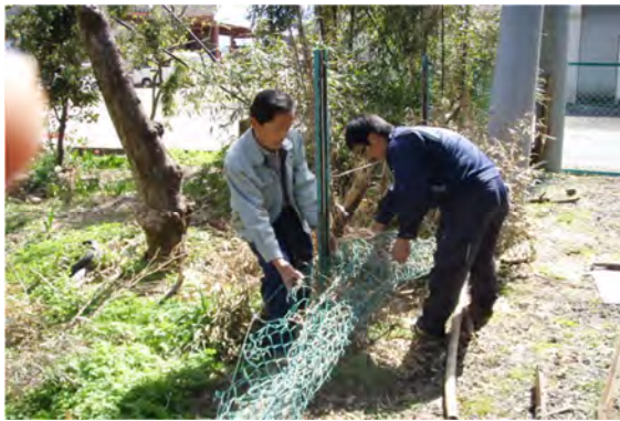
井ノ口区集落センター安全柵修繕 (H24)
