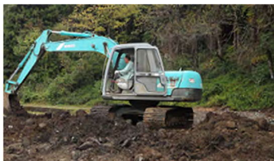
重機を借上げて行った神社周辺の整地作業
