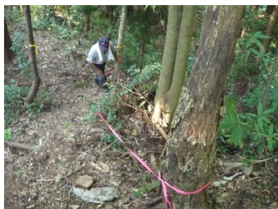
新規階段の設置箇所にテープで目印
