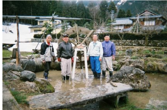
阿難祖地頭方区の水車修繕
