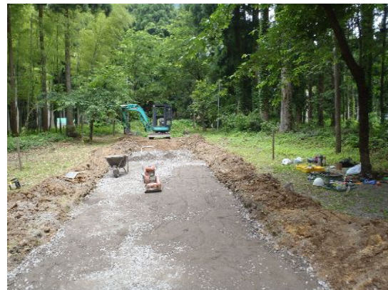
阿難祖領家地区の道路舗装
