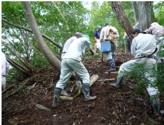
新規階段の設置作業
