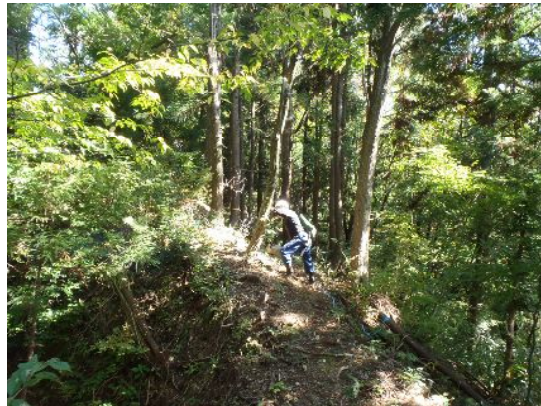
雑木伐採作業
