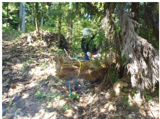
雑木伐採作業
