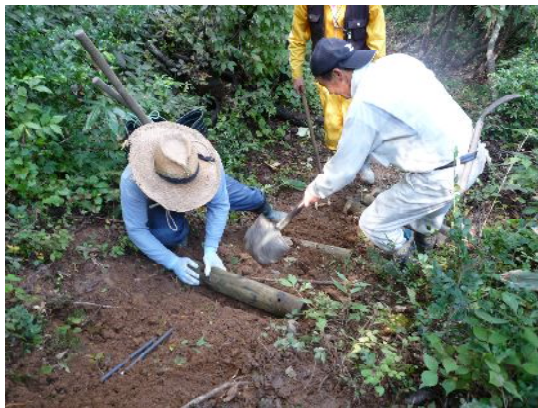
新規階段の設置作業
