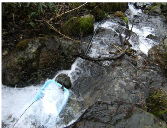
取水枡設置状況
