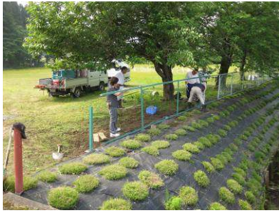
塚原区 安全柵修繕 (H23)
