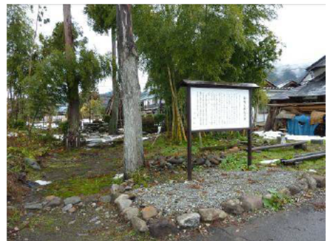
御所五郎丸の墓案内板設置作業 完成
