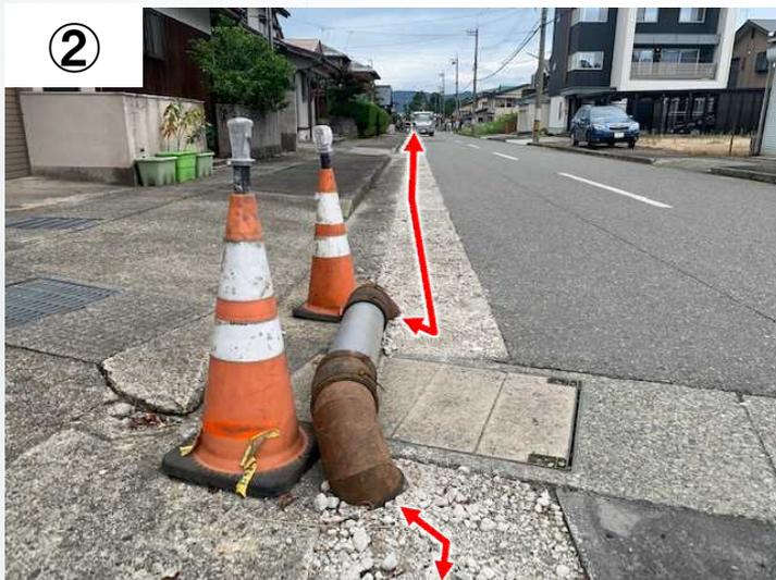
・①のように交通支障にならないように埋設しています。しかし、現場条件によっては露出する場合があります。②では、横断側溝があるためやむを得ず露出配管をしています。
