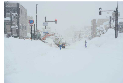
除雪作業風景
