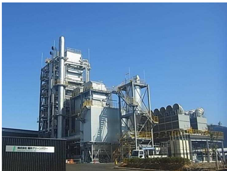
市内の木質バイオマス発電所
