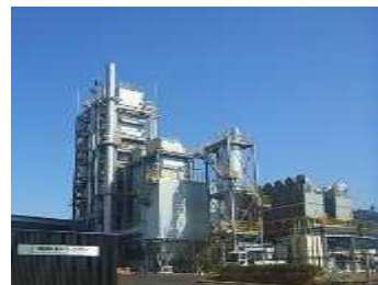
福井グリーンパワー大野発電所
