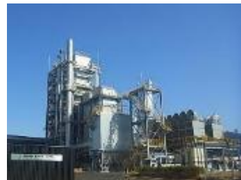
福井グリーンパワー大野発電所
