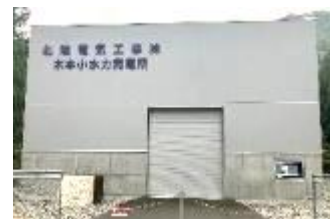
木本小水力発電所
