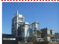
福井グリーンパワー大野発電所
