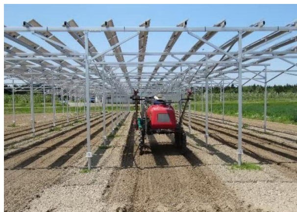
営農型太陽光発電設備
