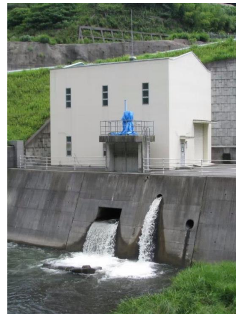
小水力発電所
