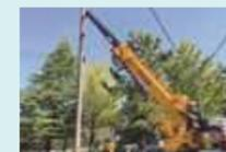
街でよく見かける電柱を建て、アンテナを取り付けています。
