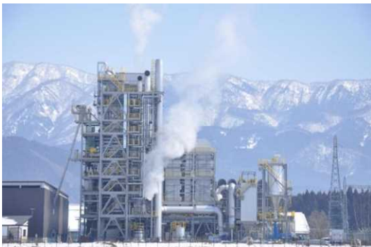
木質バイオマス発電所
