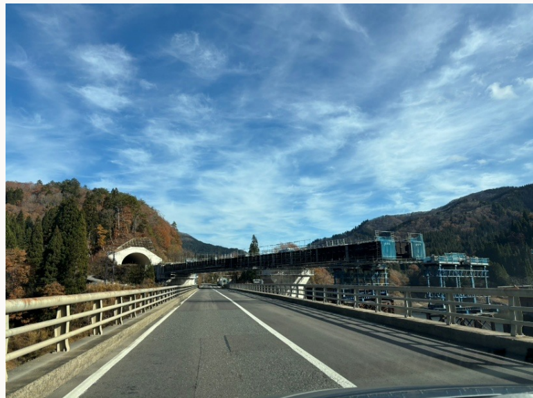
写真1 道路整備の様子（大野市箱ヶ瀬付近）
