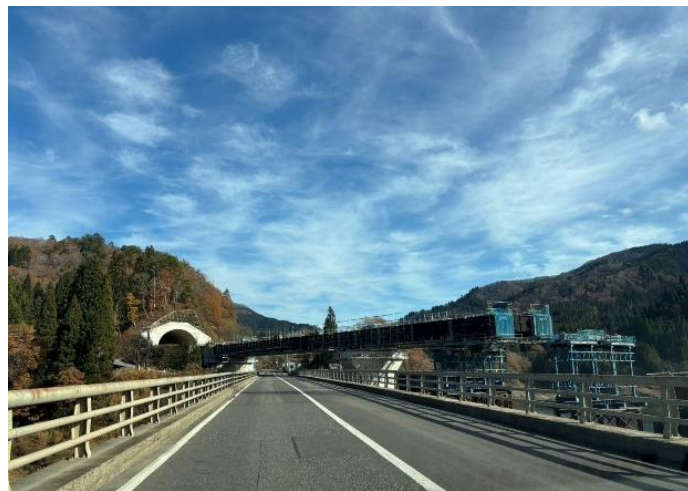
写真 3-2 道路整備の様子 撮影場所：(大野市箱ヶ瀬付近)
