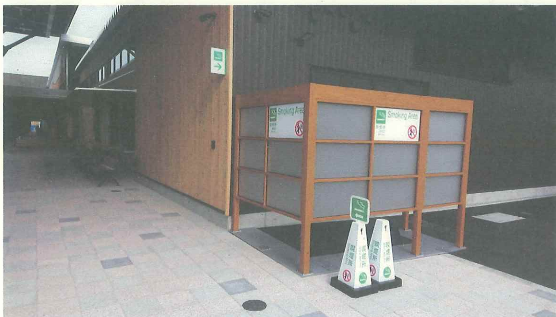
喫煙所写真（西側（調整地側）から東に向かって撮影）
