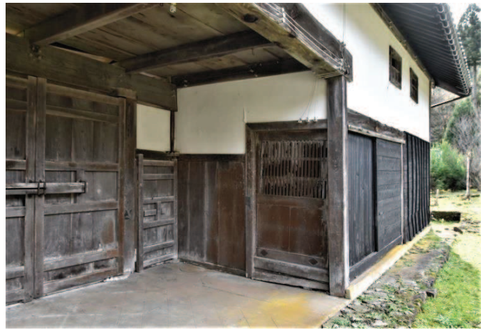
写真09 入口通路背面(南西側)
