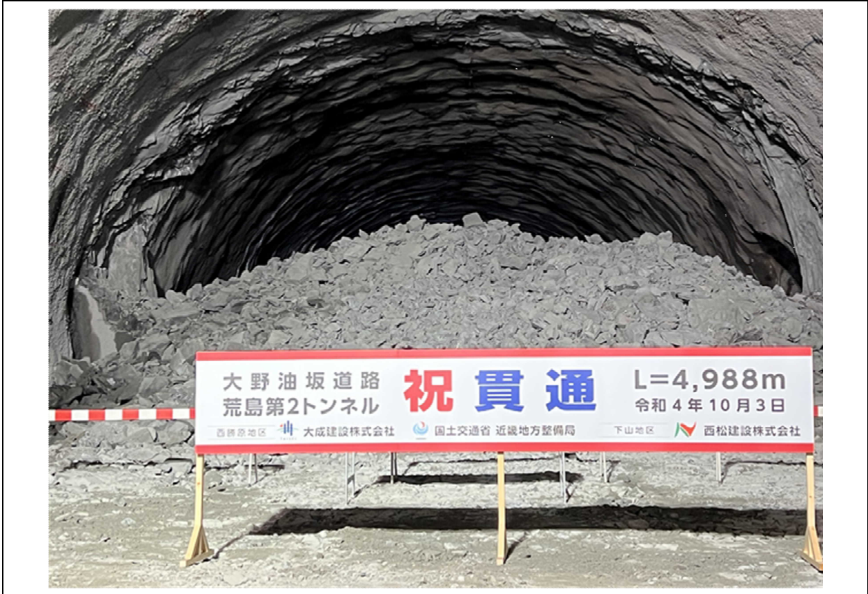
荒島第2トンネルの貫通の様子
