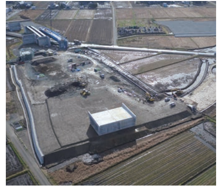
工事が進む中部縦貫自動車道大野東IC
