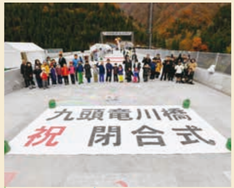
11月22日に、大野油坂道路の橋で最長となる全長約273mの九頭竜川橋の上部工が接合し閉合式が行われました。
