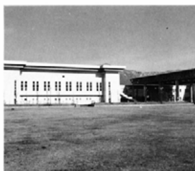
⑦エキサイト広場竣工
