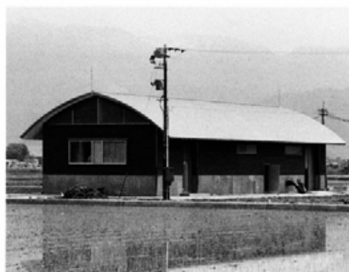
▲牛ヶ原揚水機場
