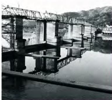
⑮水利権を取得する新鳴鹿大堰着工
