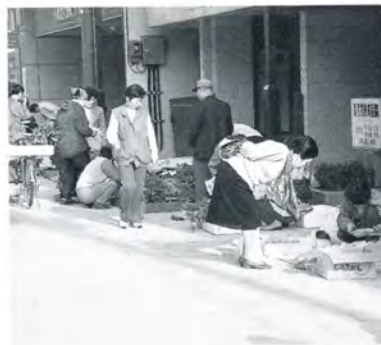
④七間通り石畳舗装が 完成し朝市も再開
