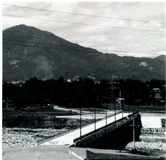
完成が待たれる阪谷新橋
