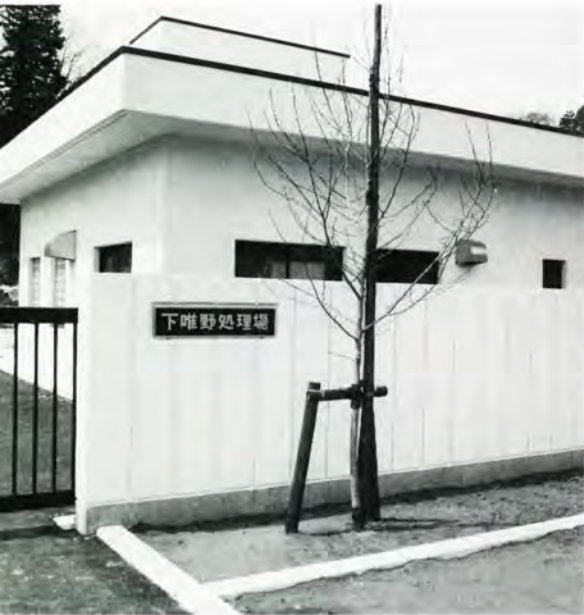
下唯野の排水処理施設
