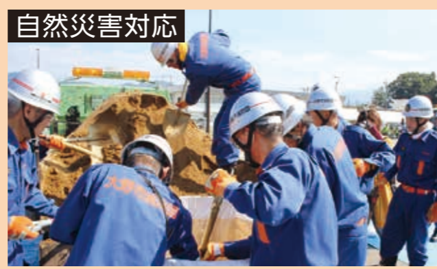
自然災害対応 地震や台風などの際は避難誘導を行い、土のうを積んで水害を防ぐなど二次災害の防止に努めます。
