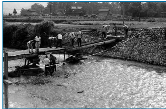
横枕の橋工事：昭和30年代撮影 清滝川に架かる横枕橋の工事中の写真です。何人もの男性が、仮の橋を作っています。橋が完成すると徒歩での移動が便利になりました。 (提供者：中村典子さん)
